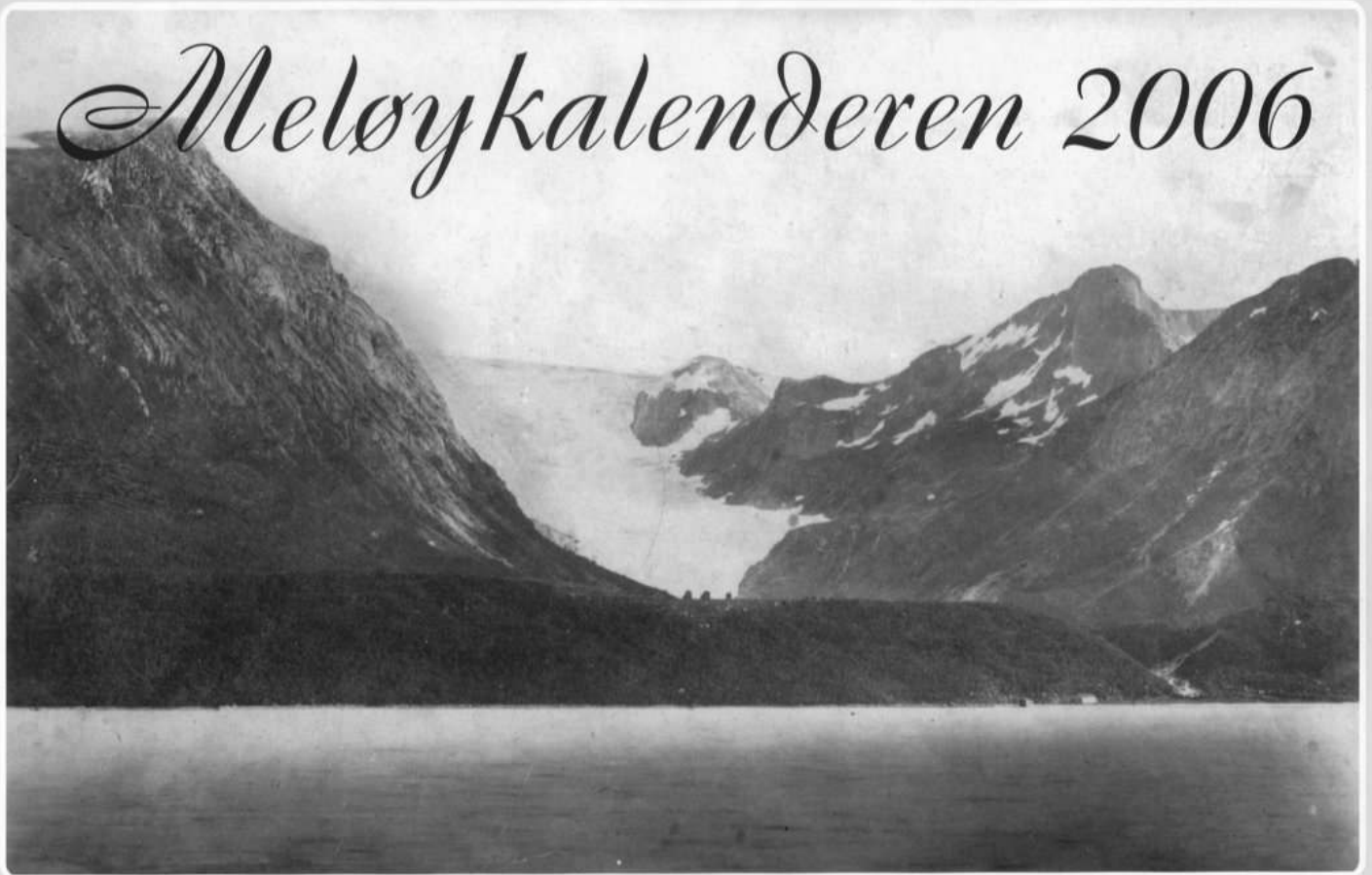
Fondalen. Postkort fra ca 1910. Husene på den mektige endemorenen sees i silhuett mot Fondalsbreen. Utlåner: Steinar Heimdahl
